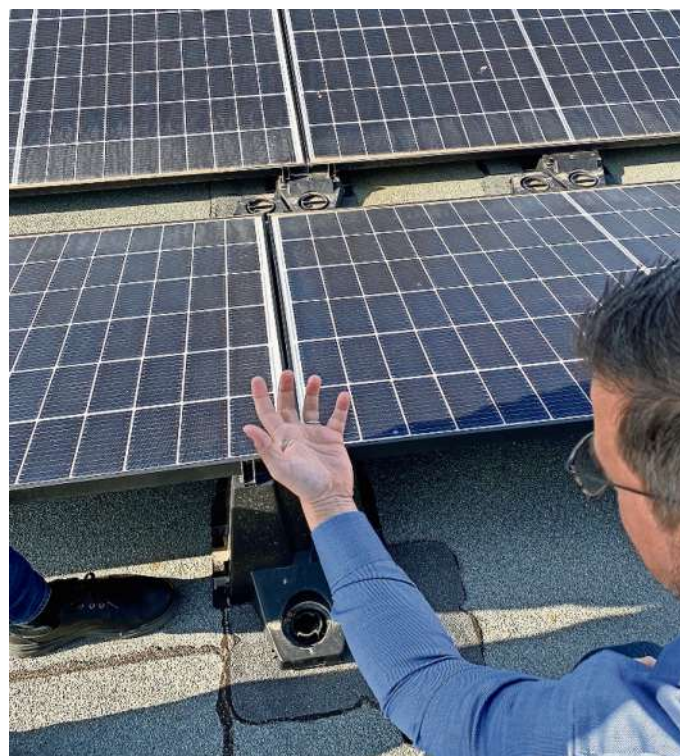
Beim Flachdach kommt es auf die Unterkonstruktion an.
