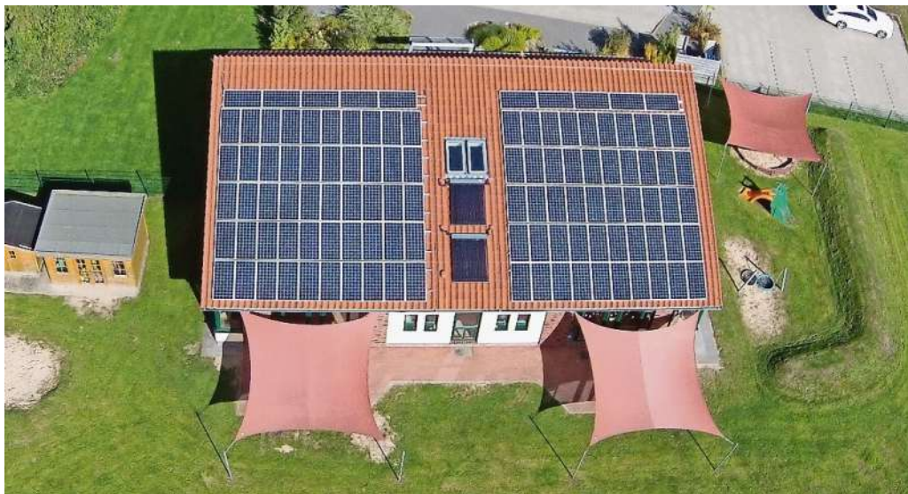
Die erste Photovoltaikanlage der Neue Energien Bremerhaven-Cuxland eG entstand 2012 auf dem Dach der Kita in Stubben.
