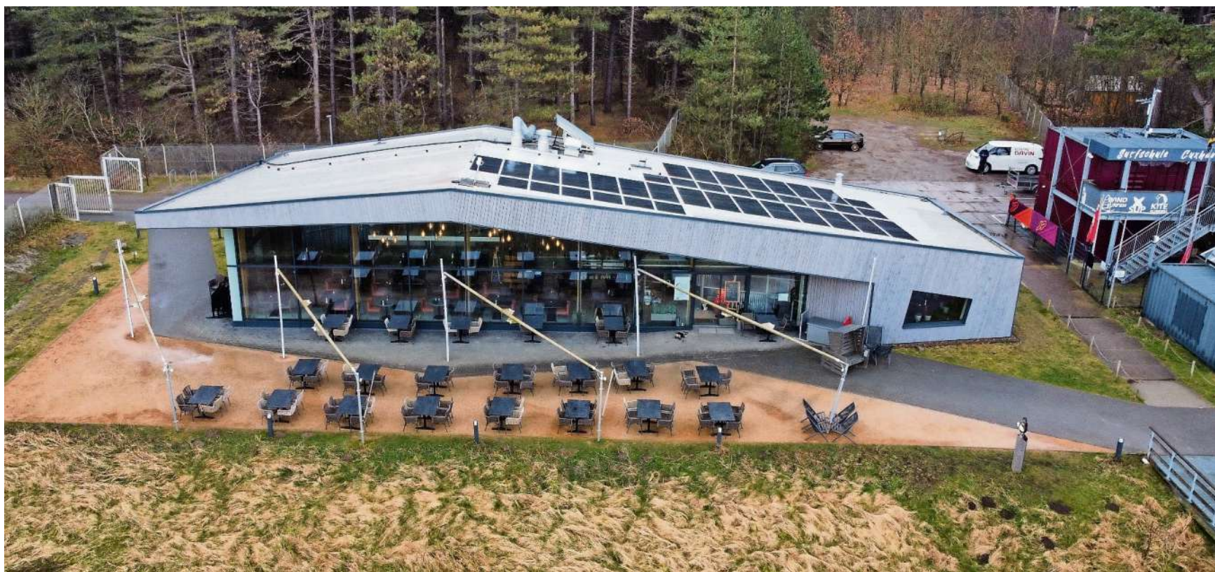
Direkt an der Küste gelegen: Schnee- und Windlast stellen an PV-Anlagen eine besondere Herausforderungen.
