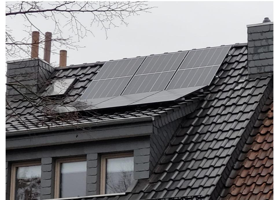
**Optimal:** Südwest bis Südost mit 20-60° Dachneigung
