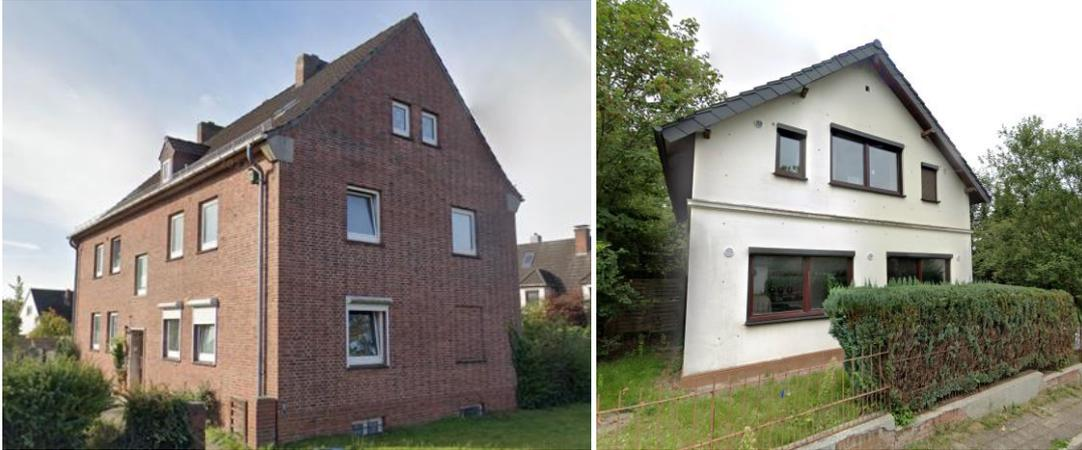
Abbildung 35: Beispielhaftes Gebäude der Baualtersklasse D (links) mit einem zweischaligen Mauerwerk gemäß Typologie und ein Gebäude mit Kerndämmung (rechts) (Fotos: TARA)
