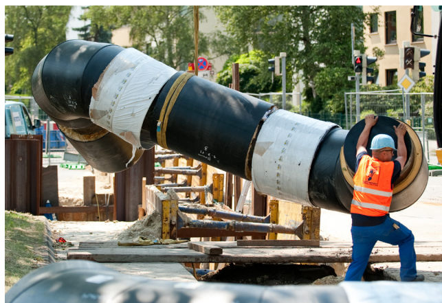
Abbildung: Anschluss eines Quartiers an das Fernwärmenetz (Foto: wesernetz)
