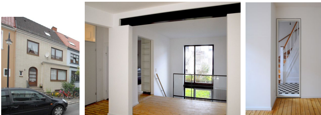
Straßenansicht vor der Sanierung, Lichtdurchfluteter offener Wohnbereich nach Sanierungsumbau Fotos: Theis Janssen
