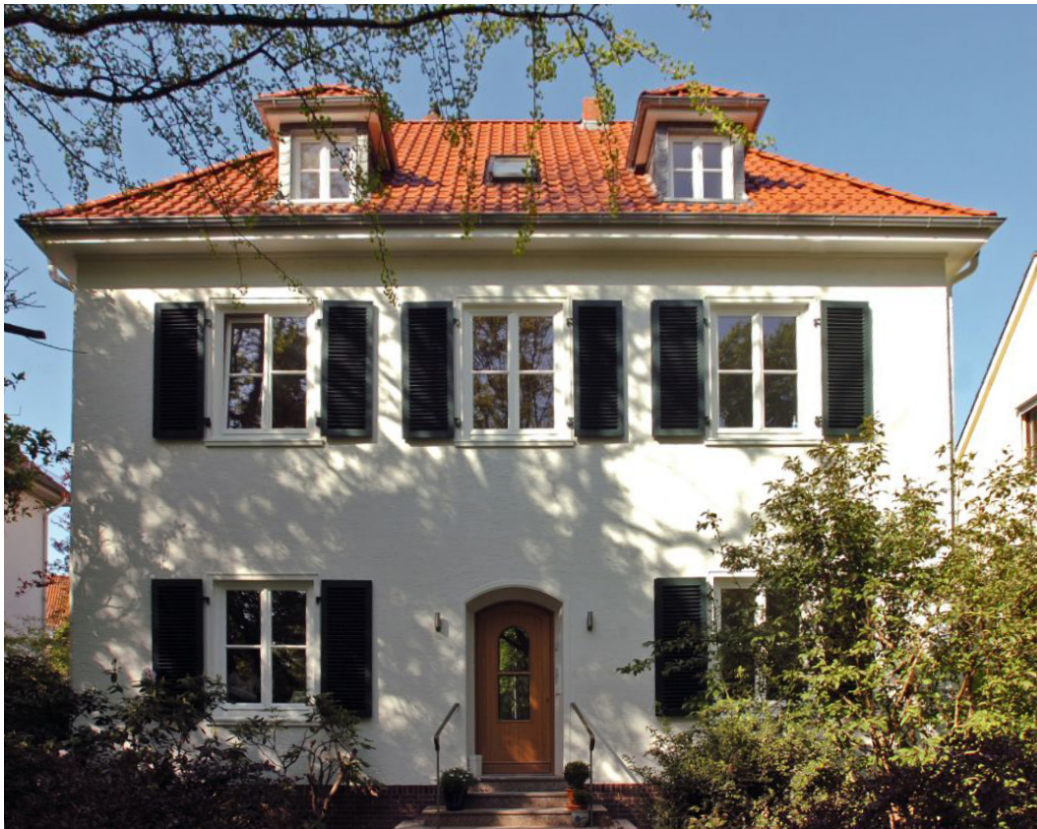
Straßenfassade nach Sanierung
