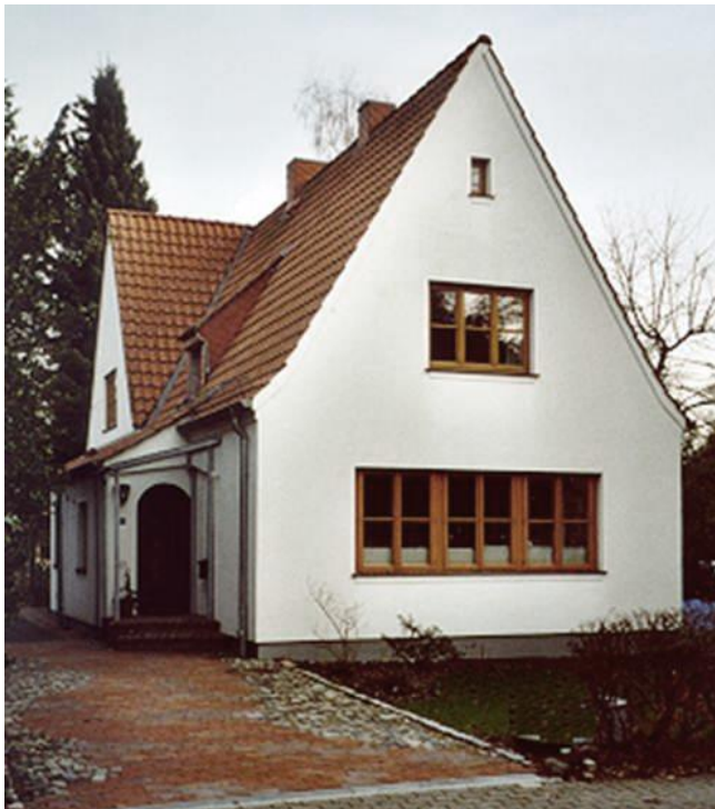
Straßenansicht nach Sanierung
