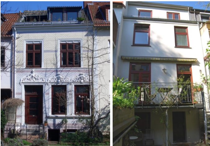
Fassaden vor der Sanierung
