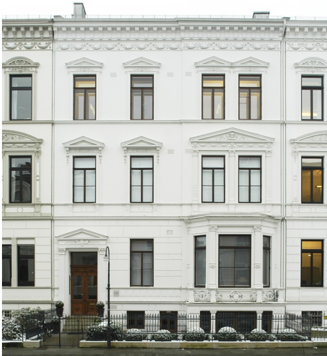
Straßenfassade nach Sanierung
