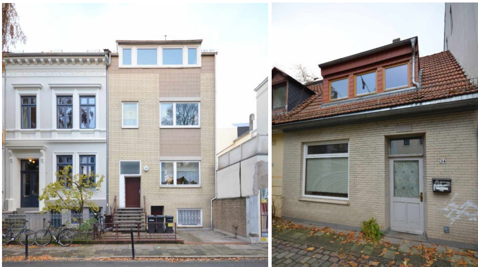
Abbildung 2-47 Beispiele für „kaputtsanierte“ Fassaden an Bremer Häusern
