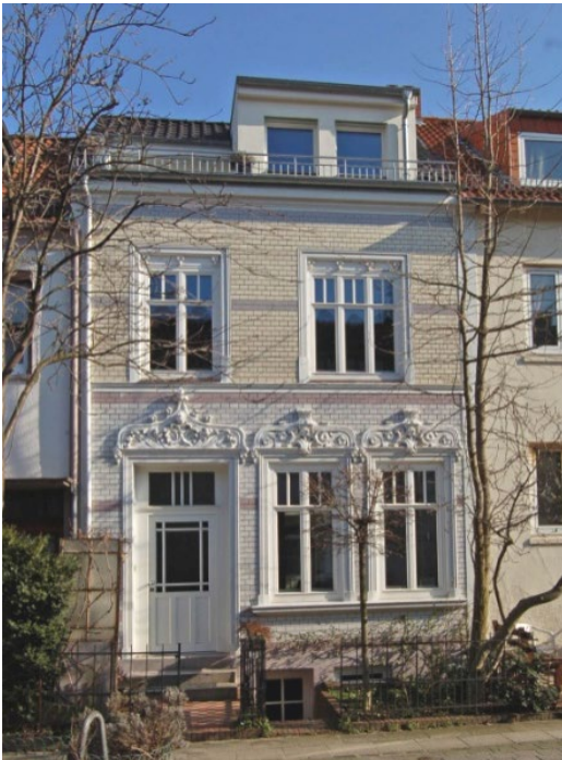
Sanierte historische Straßenansicht
