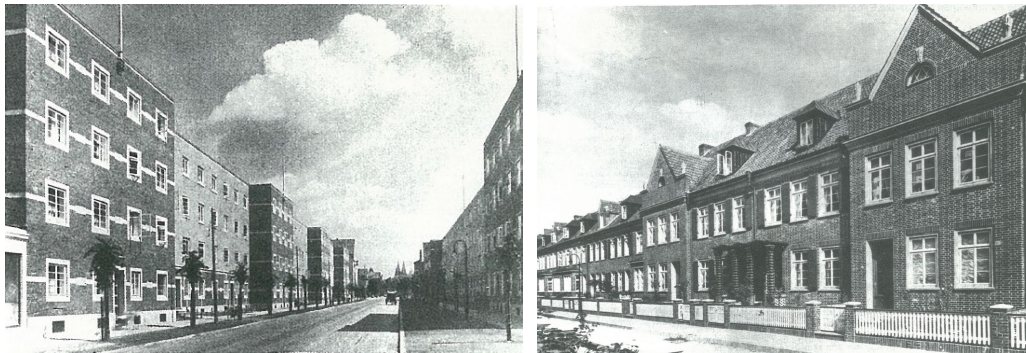
Abbildung 2-12 Wohnanlage Friedrich-Ebert-Straße, 1929-1931 (l.) und Reihenhäuser in der Ingelheimer Straße, 1925 (r.)
