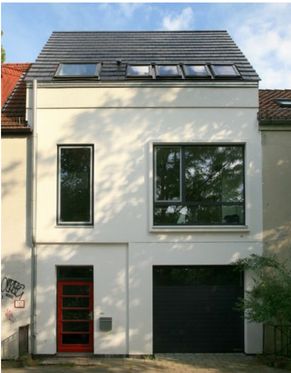
Straßenfassade nach der Sanierung
