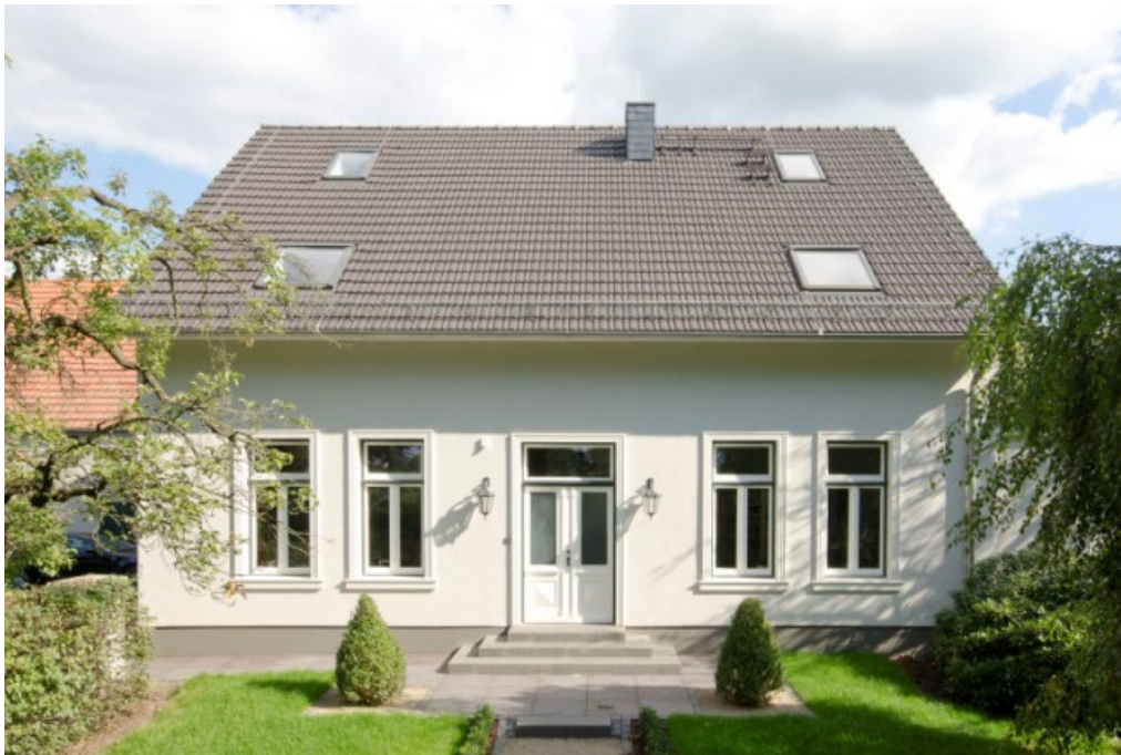
Eingangsfassade nach Sanierung
