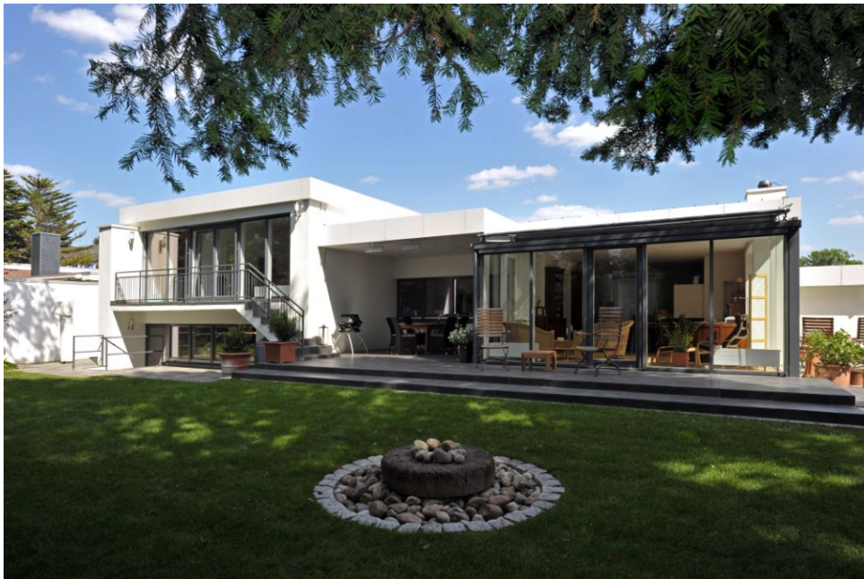
Gartenansicht nach der Sanierung
