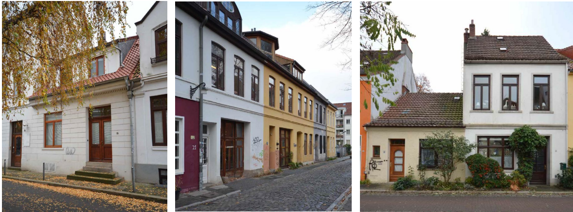
Abbildung 2-8 Frühe eingeschossige Bremer Häuser in der Rutenstraße, Heinrichstraße und Albrechtstraße. Die Häuser wurden später entweder aufgestockt oder die Dachräume wurden ausgebaut
