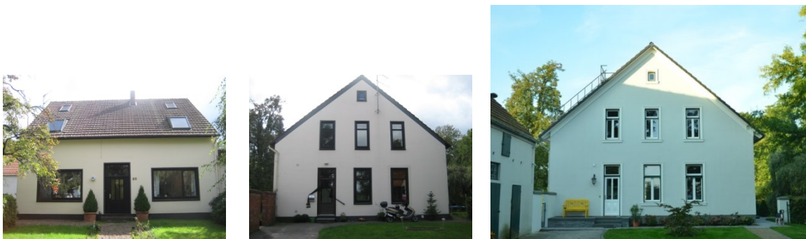
Eingangsfassade und Giebelseite vor der Sanierung (u.l. + u.m.) und sanierte Giebelansicht (u.r.) Fotos: Ludwig Schilling
