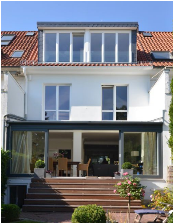
Gartenansicht nach der Sanierung
