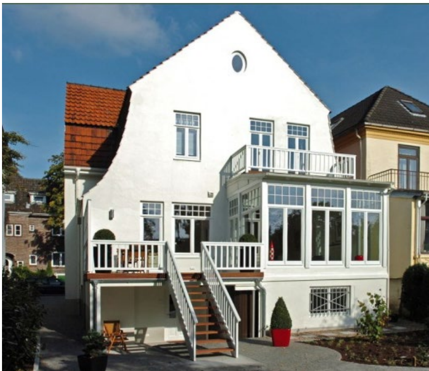
Gartenansicht nach Sanierung
