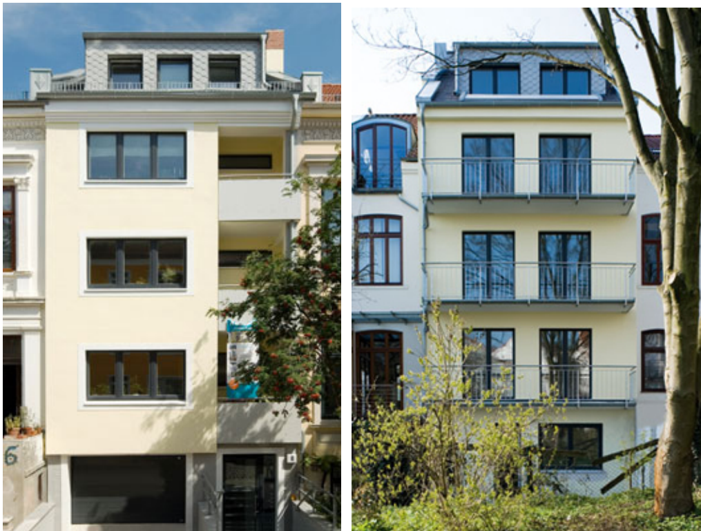
Ansichten nach der Sanierung Fotos: K. Seidenberg
