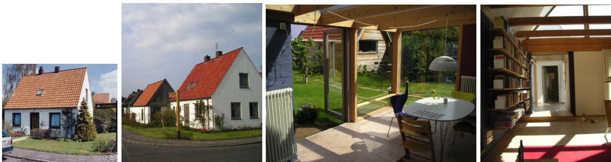
Ansichten vor und nach der Sanierung, Innenraum der Erweiterung und des Altbaus Fotos: S. + J. Grube
