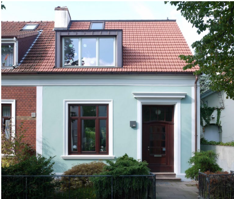
Straßenfassade nach Sanierung
