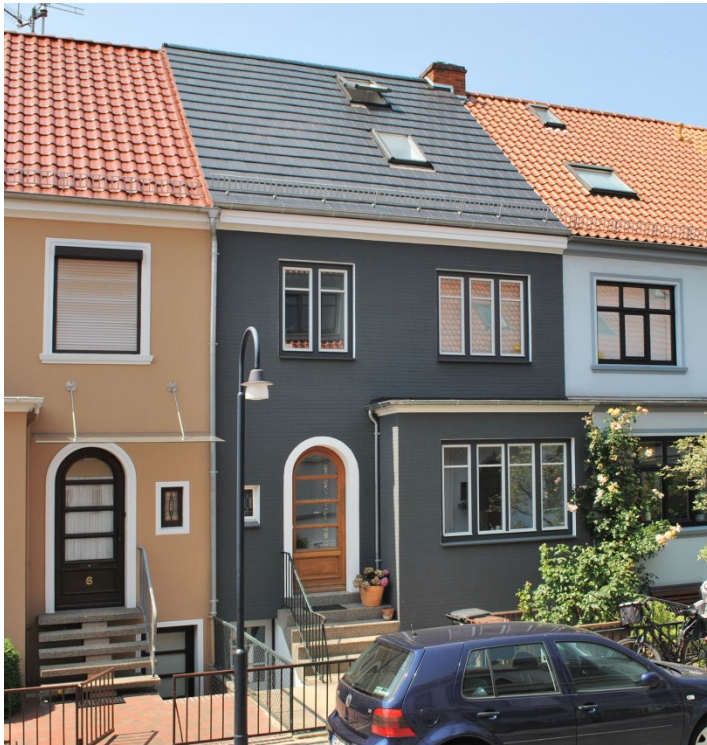
Straßenfassade nach Sanierung
