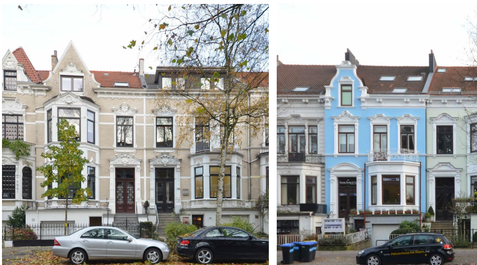
Abbildung 2-33 Großbürgerliche Bremer Häuser im Parkviertel
