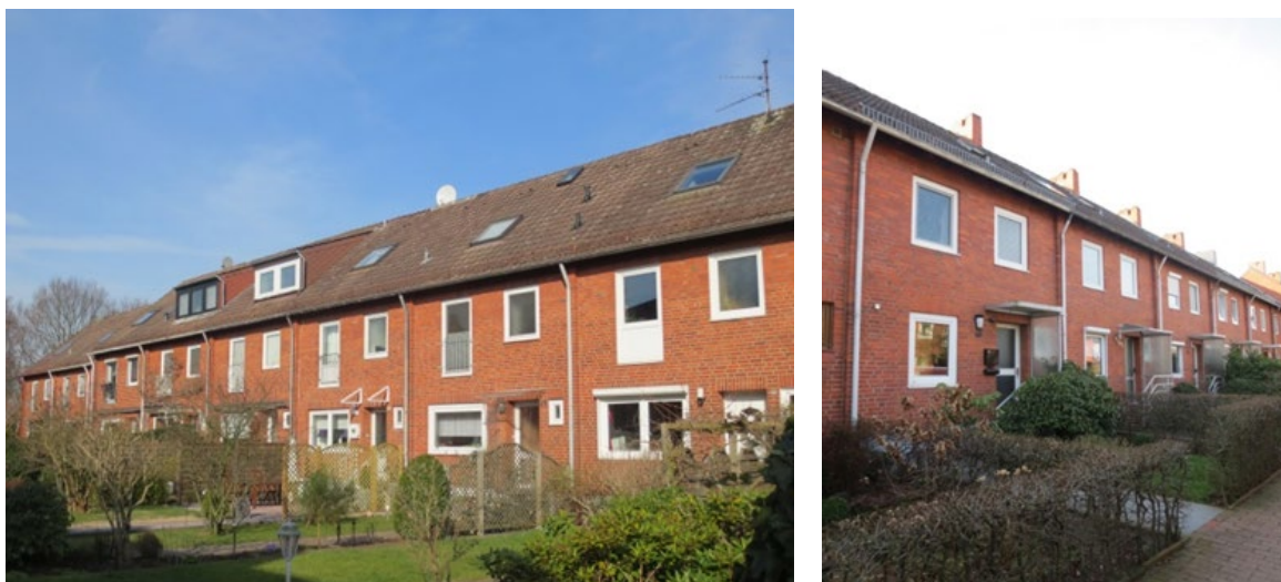
Abbildung 2-19 Reihenhäuser in der Bardowickstraße, Gartenstadt Vahr
