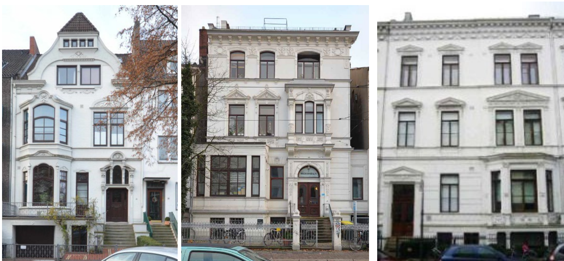
Abbildung 2-32 Großbürgerliche Bremer Häuser: Parkallee, Am Dobben, Kohlhöckerstraße
