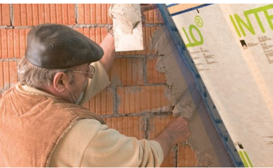
Auf's Detail kommt es an: Einputzen eines Gewebeanschlussbandes an die luftdichte Ebene
