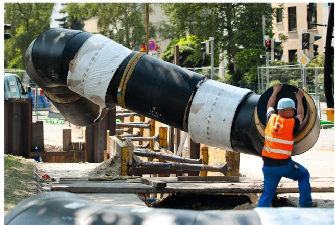
Abbildung: Anschluss eines Quartiers an das Fernwärmenetz
