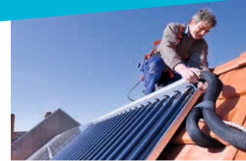
„Solarthermie“ nutzt die Energie der Sonne zur Warmwasserbereitung im Haushalt, aber auch zur Unterstützung der Raumheizung. Es wird also kein Strom sondern Wärme produziert. Solar Kollektoren auf dem Dach leiten die Wärme in einen Pufferspeicher, der sie an den Trinkwasserkreis oder das Heizungssystem weitergibt. Durch eine Solarthermie-Anlage können mit vergleichsweise geringen Kosten erhebliche Mengen an fossilen Brennstoffen eingespart werden.
