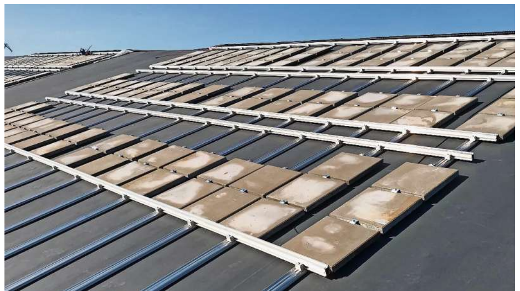
Betonplatten bilden ein sicheres Fundament für die Photovoltaikmodule.
