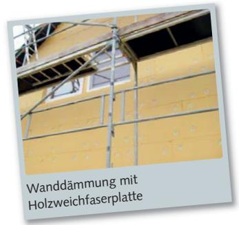
Wanddämmung mit Holzweichfaserplatte
