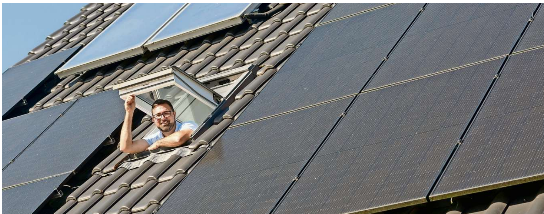
Den Großteil des erzeugten Stroms vom Dach verbraucht die vierköpfige Familie von Serkan Ak selbst. Foto: Schimanke/energiekonsens
