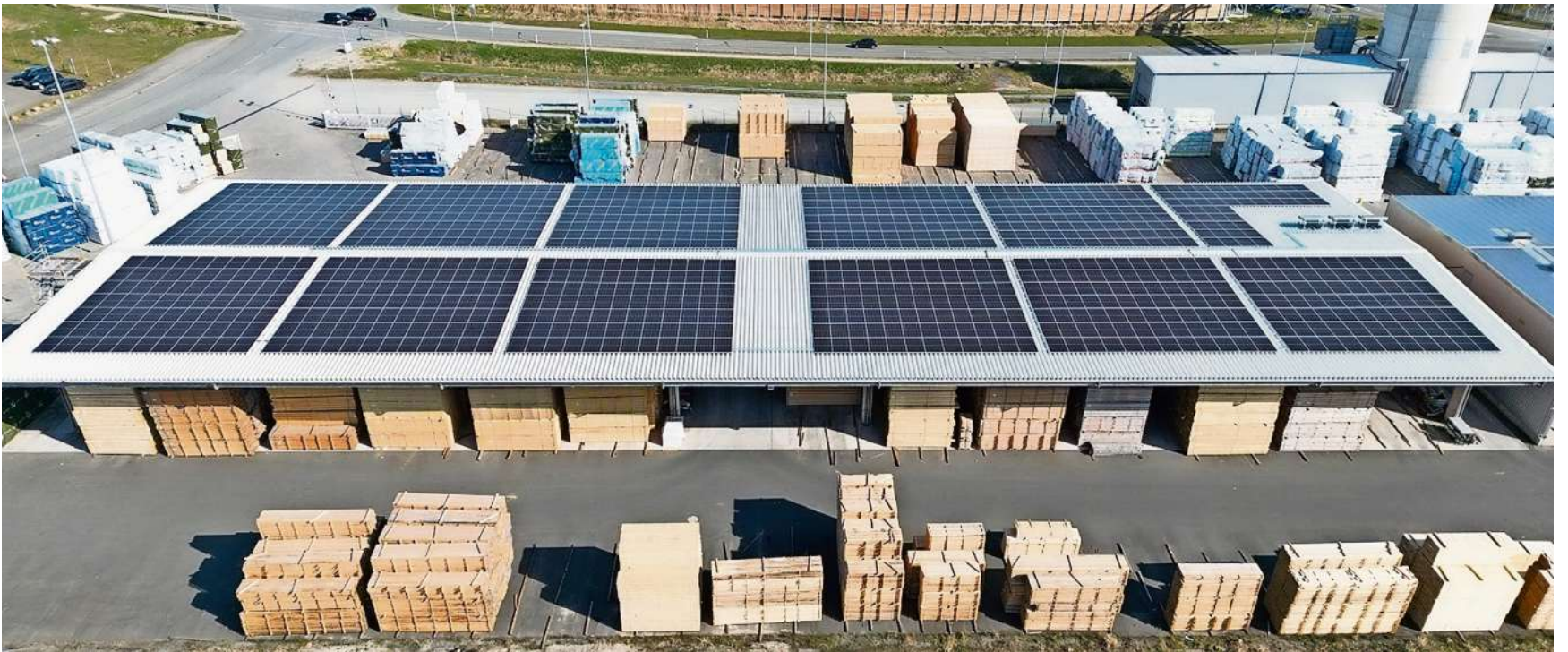
Großflächig mit Photovoltaik ausgestattet: das Dach der Halle 18, in der sich das Brettschichtwerk befindet. Foto: energiekonsens
