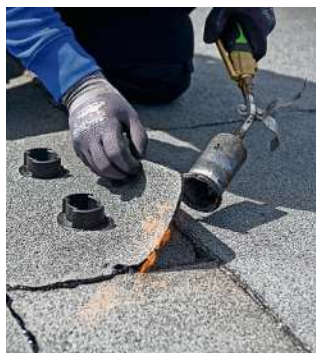
Schweißerarbeiten für ein PV-System, das großen Windlasten standhält und trotzdem nicht zu schwer für Dächer ist.
