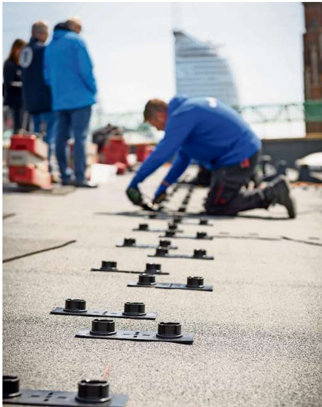
Insgesamt 530 Quadratmeter Fläche nehmen die 58 eingeklickten Module auf dem Dach des Boardinghouse Im-Jaich ein. Fotos: Schimanke / energiekonsens
