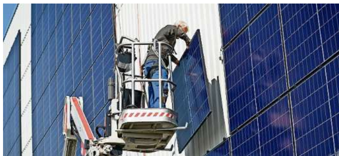
Durch ein statisches Fachbüro wird der sichere und fachgerechte Einbau der Solarmodule auf einer ebenen Fläche sichergestellt.
