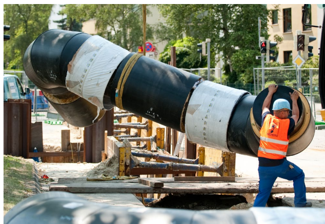
Abbildung: Anschluss eines Quartiers an das Fernwärmenetz (Foto: wesernetz)
