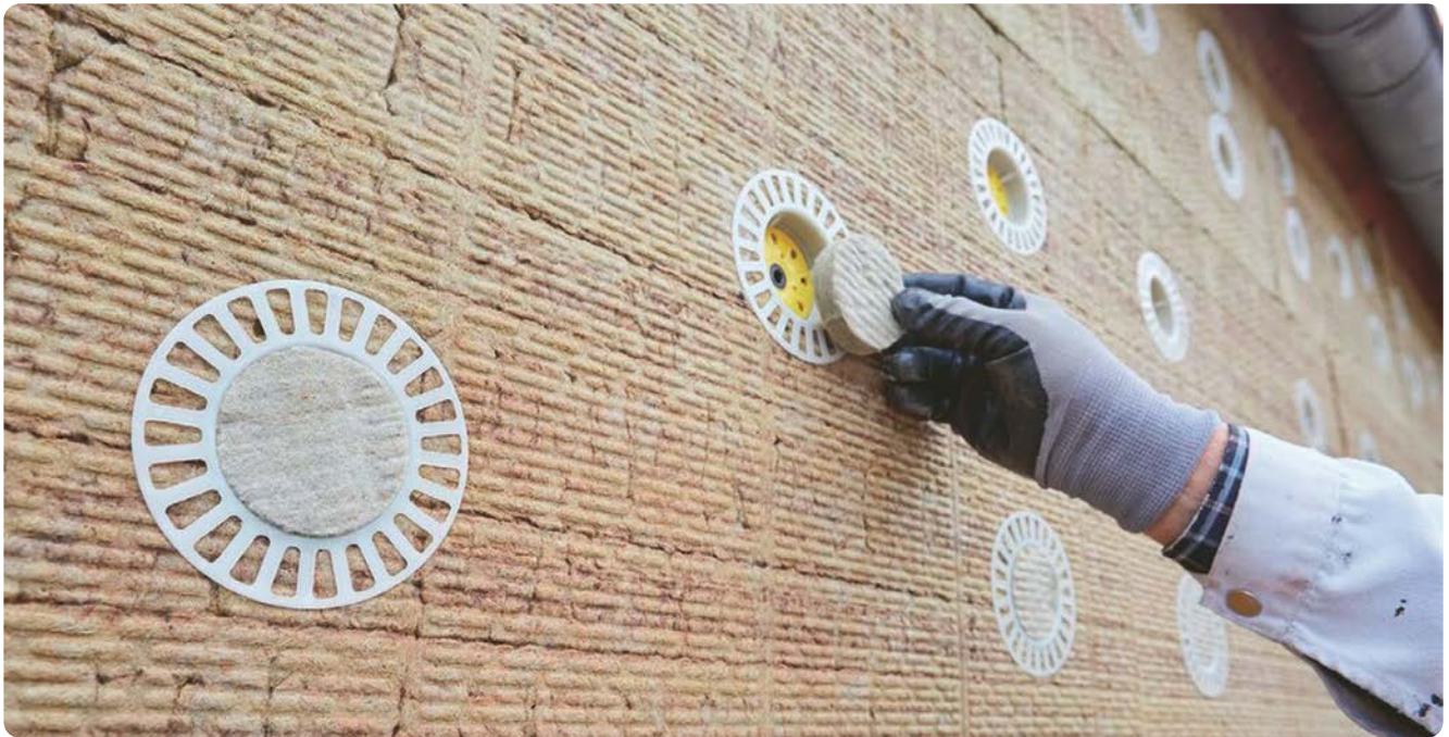
Die an ein Wärmedämmverbundsystem (WDV)-System gestellten Anforderungen wachsen stetig. Eine fachgerechte Verdübelung ist die Grundlage für die sichere Befestigung von WDV-Systemen
