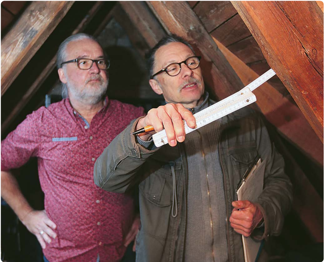
Eine gute Beratung bei Planung und Durchführung einer Dachsanierung ist unabdingbar.
