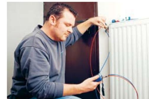
▲ Einregulieren und gleichzeitiges Messen an jedem Heizkörper eröffnet neue Wege der Anlagen-Optimierung.
