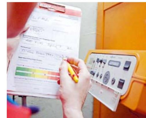
▲ Nach Abschluss der Wartungsarbeiten wird eine Abgasmessung durchgeführt. Die gemessenen Werte werden mit den Angaben in den jeweiligen Unterlagen verglichen. Abweichungen, insbesondere bei den Kohlendioxid- und Kohlenmonoxid-Werten werden über die jeweiligen Brenneinstellungen (Brennerdruck Kleinlast/Großlast, Gas-Luft-Verhältnis) korrigiert bzw. optimiert.
