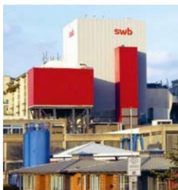
**Fernwärme** aus einem Heizkraftwerk ist in der Regel eine umweltfreundliche Versorgungsvariante, da sie aus einem „Abfallprodukt“ der Stromversorgung oder aus Industrieprozessen bereitgestellt wird, nämlich der Abwärme, die sonst nutzlos an die Umwelt abgegeben wird. Trotz hoher Wärmepreise ist sie vor allem im Niedrigenergiehaus oft wirtschaftlich, da die Investitionen in die Anlagentechnik für den Hausbesitzer relativ niedrig sind. Außerdem ist der Platzbedarf gering.
