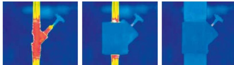
► Erfordert die zentrale Warmwasserversorgung sehr lange Rohrleitungsstrecken, führt die Zirkulationsleitung zu Wärmeverlusten. Um dieses zu vermeiden, ist auf eine korrekte Planung und Ausführung der Dämmung zu achten.
