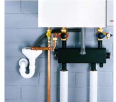
▲ Das bei der Brennwertnutzung anfallende Kondensat kann über die öffentliche Kanalisation abgeführt werden. Kondensat aus Gas-Brennwertgeräten, die für Ein- und Zweifamilienhäuser eingesetzt werden, kann in der Regel unbehandelt (ohne Neutralisation) in die Kanalisation eingeleitet werden. Bei Ölbrennwertgeräten ist manchmal eine Neutralisation des sauren Kondensats erforderlich. Ihr Abwassernetzbetreiber vor Ort gibt Ihnen hierzu eine gesicherte Auskunft.
