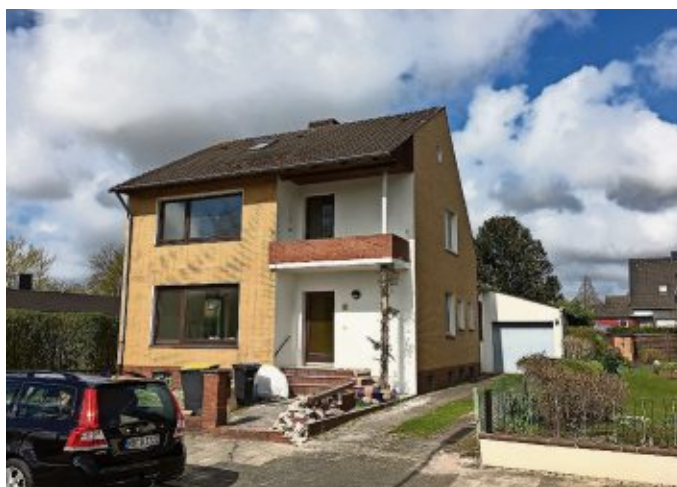
Vom Altbau zum Effizienzbau: Der Vorher- und Nachher-Effekt
