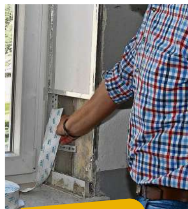
Die 1. Ebene trennt das Raumklima von äußeren Einflüssen. Diese Dichtungsebene muss luftdicht sein. Das Abklebeband ist dabei dampfdichter als die Materialien der äußeren Ebene.
