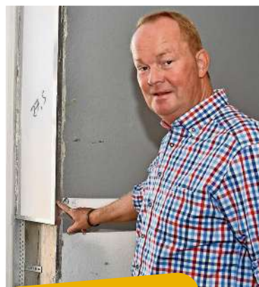
Wilfried Mehrrens , Geschäftsführer der Tischlerei Ordemann aus Beverstedt, erklärt die drei Dichtungsebenen des fachgerechten Festereinbaus. Die Fenster müssen innen dichter als außen eingebaut sein. Es wird zwischen drei Dichtungsebenen unterschieden.
