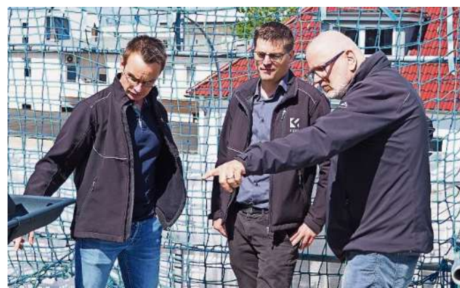
Im Austausch vor Ort: Vertreter der FBG und von energiekonsens besichtigen die neue Indach-Photovoltaikanlage am Fischkai 31. Foto: John/energiekonsens
