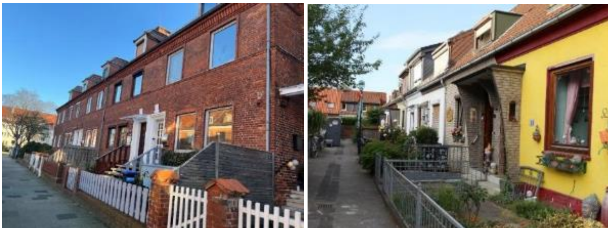
Abbildung 51: typische Außenwände Typ 1 und Typ 4 +5 (Fotos: TARA Ingenieurbüro).
