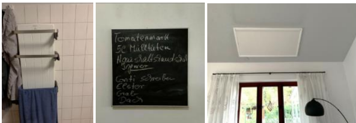
Abbildung 64: Einsatz von Elektrostrahlplatten (Fotos: TARA Ingenieurbüro)
