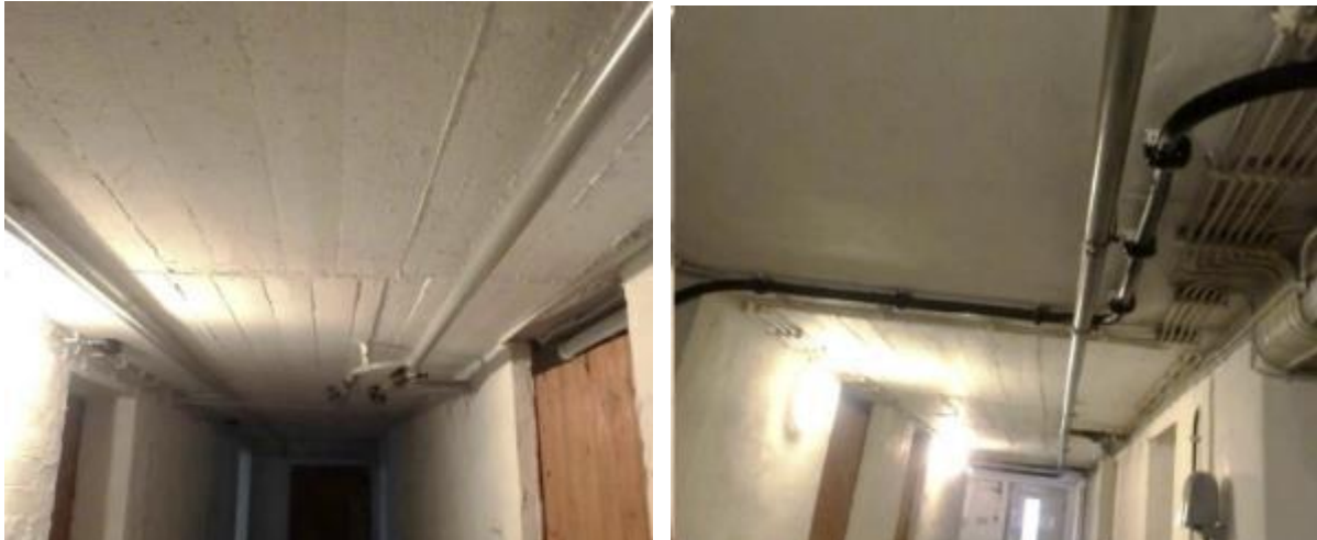
Abbildung 56: Kellerdecke im Quartier (Foto: TARA Ingenieurbüro).
