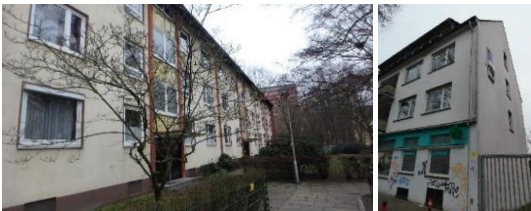
Abbildung 55: Fenster im Quartier (Fotos: TARA Ingenieurbüro).
