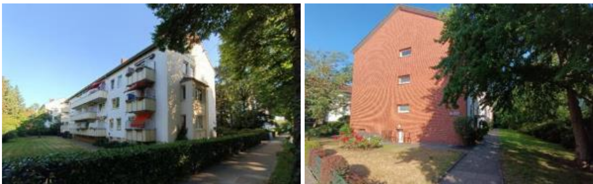
Abbildung 81: Ansichten im Bereich westlich der Stader Straße (Fotos: eco)
