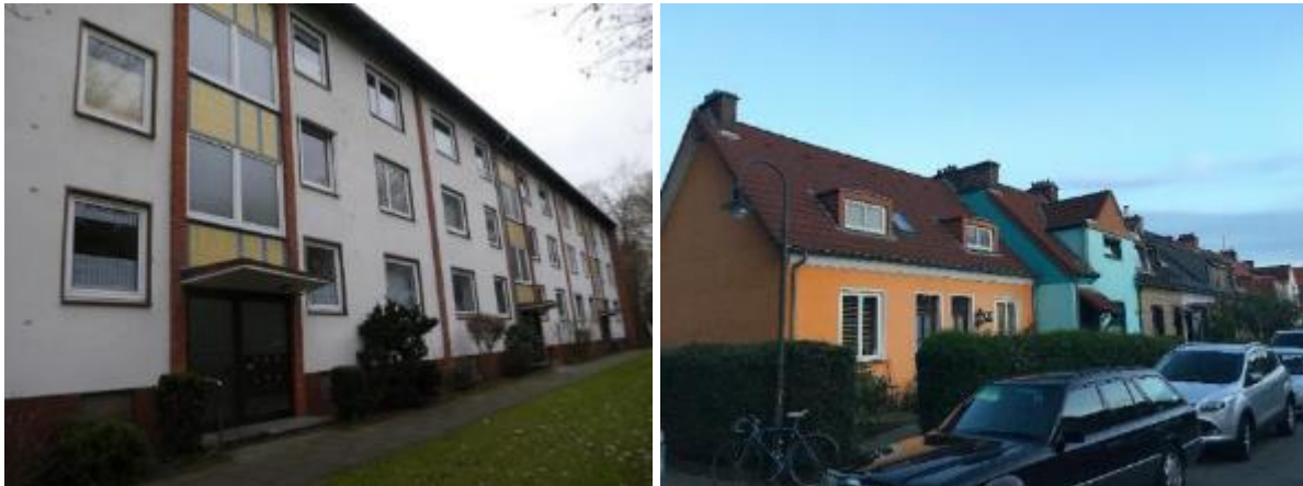
Abbildung 49: Typische Außenwände Typ 3 und Typ 4 +5 (Fotos: TARA Ingenieurbüro).
