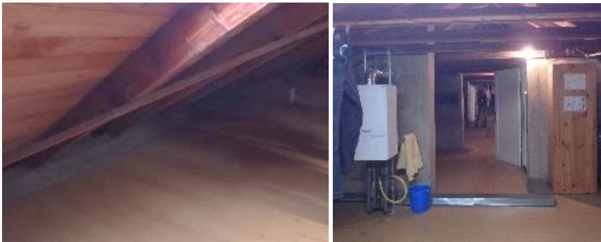
Abbildung 54: typischer Dachboden Typ 3 (Fotos: TARA Ingenieurbüro).
