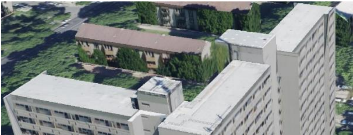
Abbildung 52: Ansicht Dach Gebäudetyp 2 (Quelle: GeoBasis-DE / Landesamt GeoInformation Bremen [2023])
