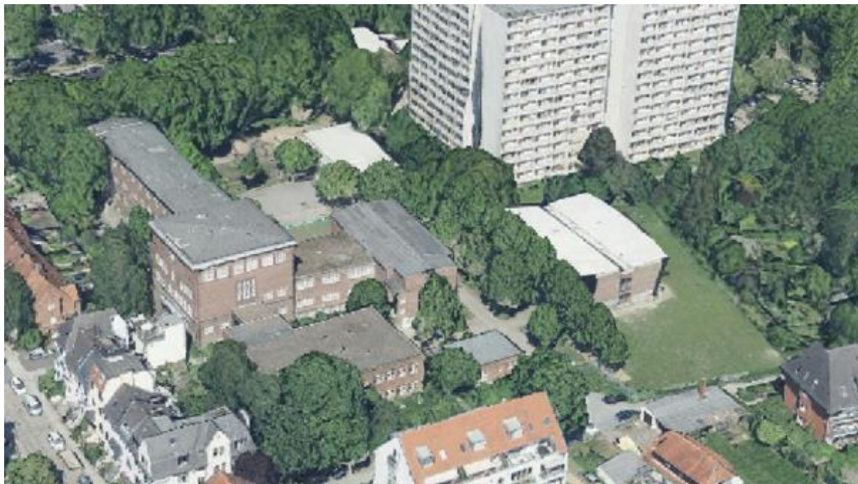
Abbildung 77: Blick von Südwesten auf die Schule an der Schaumburger Straße (Quelle: GeoBasis-DE / GeoInformation Bremen [2023])
